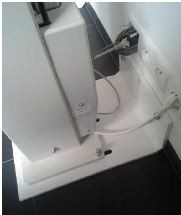
Rysunek 7 Zamontowanie aparatu na płycie montażowej
