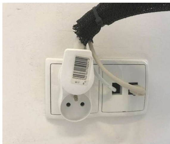
Rysunek 8b Drugi sposób podłączenia przewodów do gniazda RJ45, kabla ekspozycji i gniazda zasilającego
