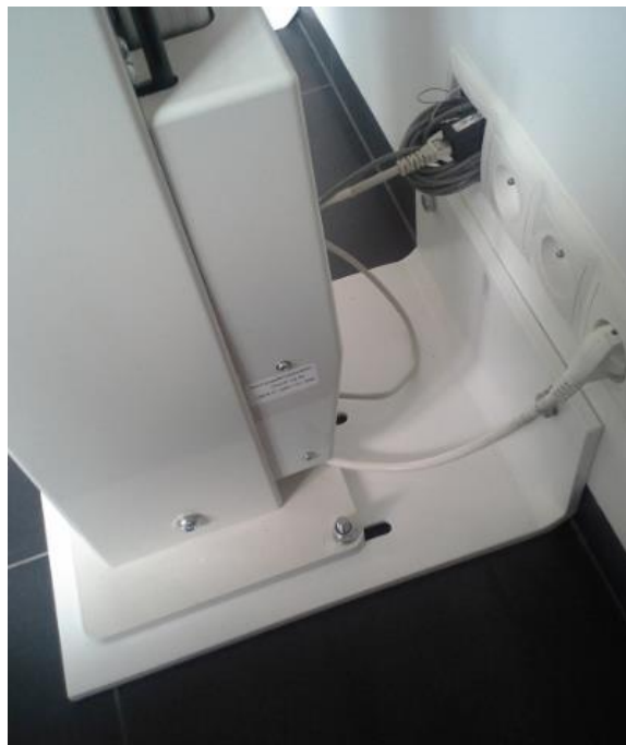
Rysunek 7 Zamontowanie aparatu na płycie montażowej
