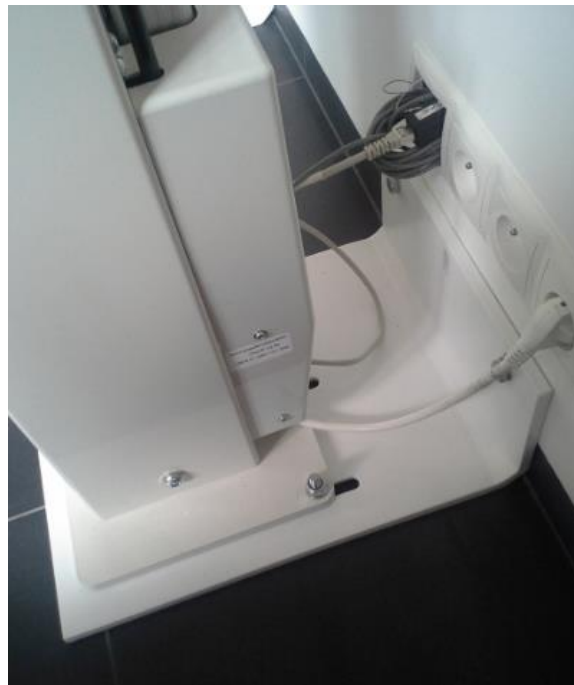
Rysunek 7 Zamontowanie aparatu na płycie montażowej
