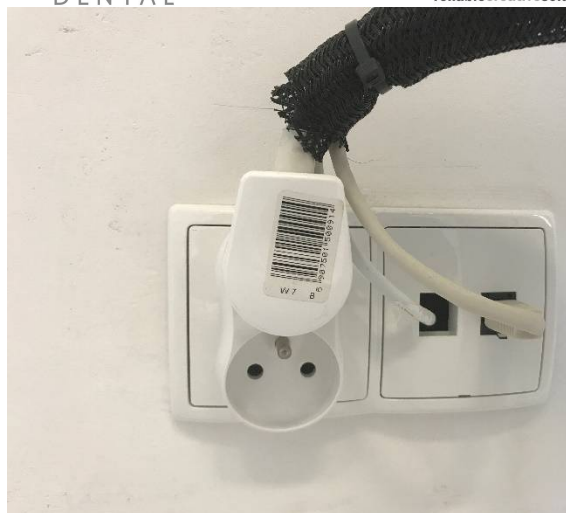
Rysunek 8b Drugi sposób podłączenia przewodów do gniazda RJ45, kabla ekspozycji i gniazda zasilającego
