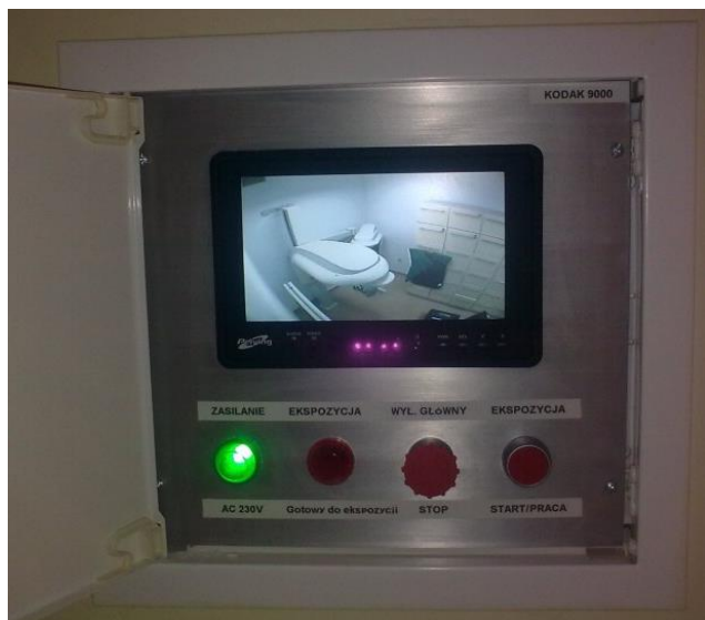
Rysunek 10 Przykładowe rozwiązanie panelu operatora z podglądem na pacjenta
